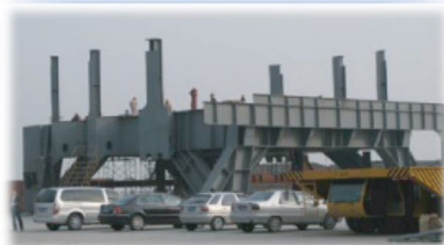
Plataforma de perfuração
